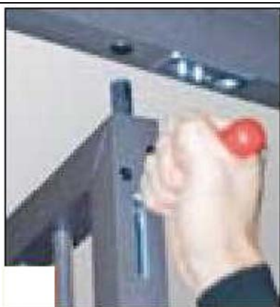
Fig.17: Montaggio dell'anta con perno del cardine superiore reintrodotto
