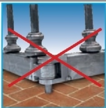
Fig.19: Danneggiamento cerniera
